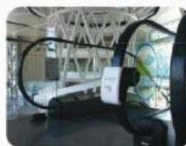
Edificio posco en china
